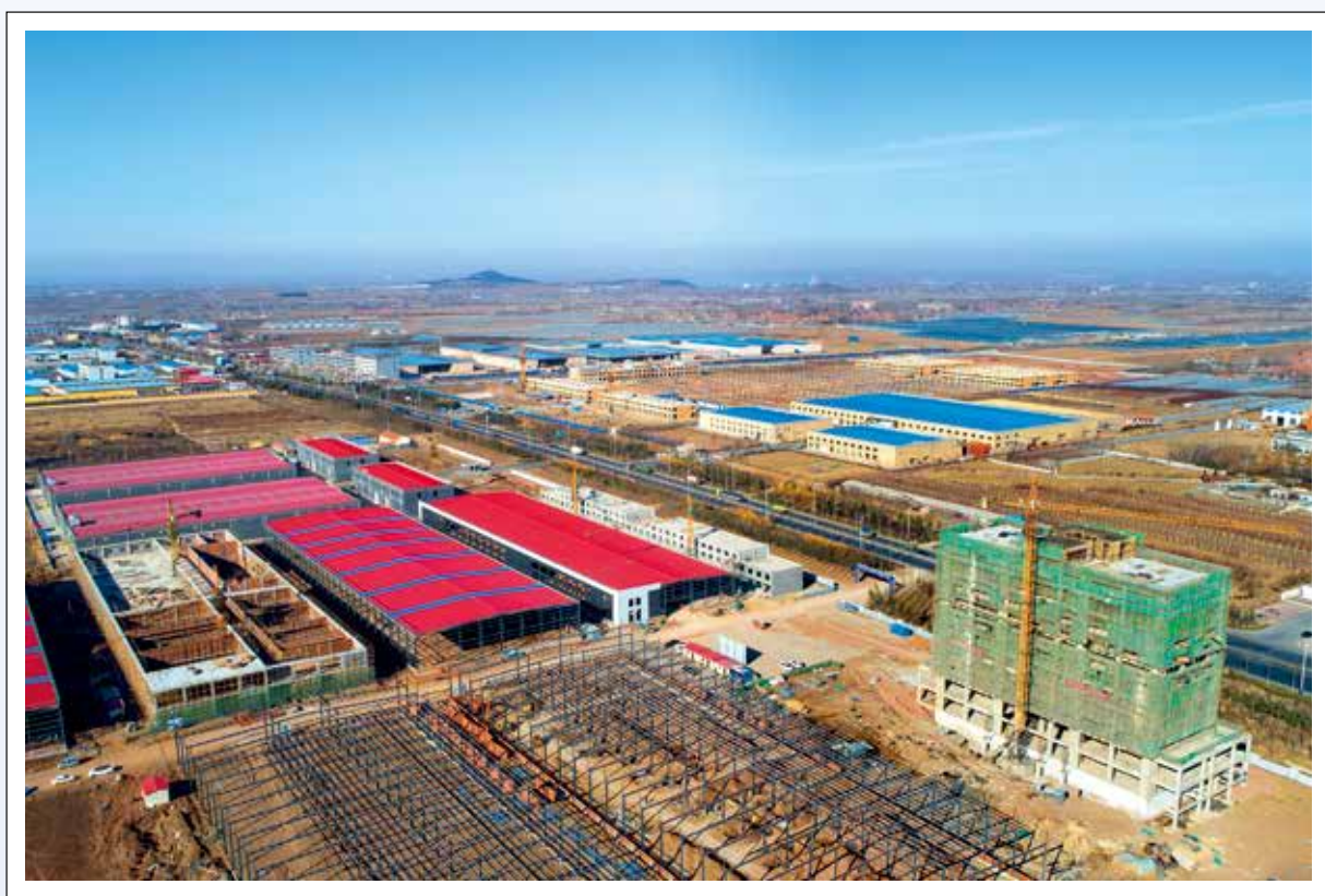
安丘农谷科技园在建项目
