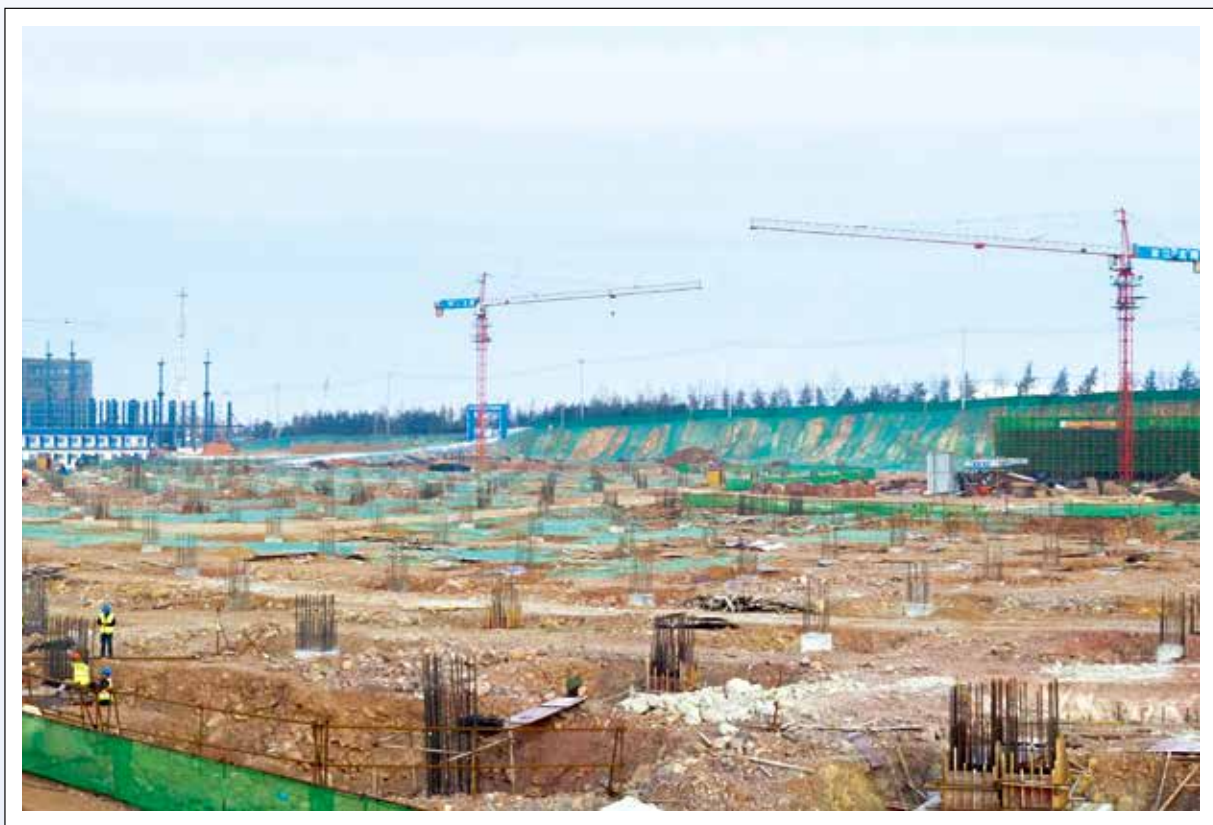
韵达山东(安丘)快递电商总部基地在建项目
