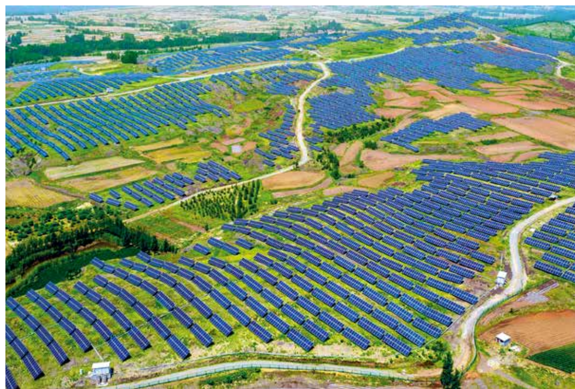
安丘市 140 兆瓦光伏扶贫项目
