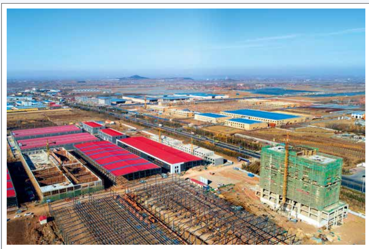
安丘农谷科技园在建项目
