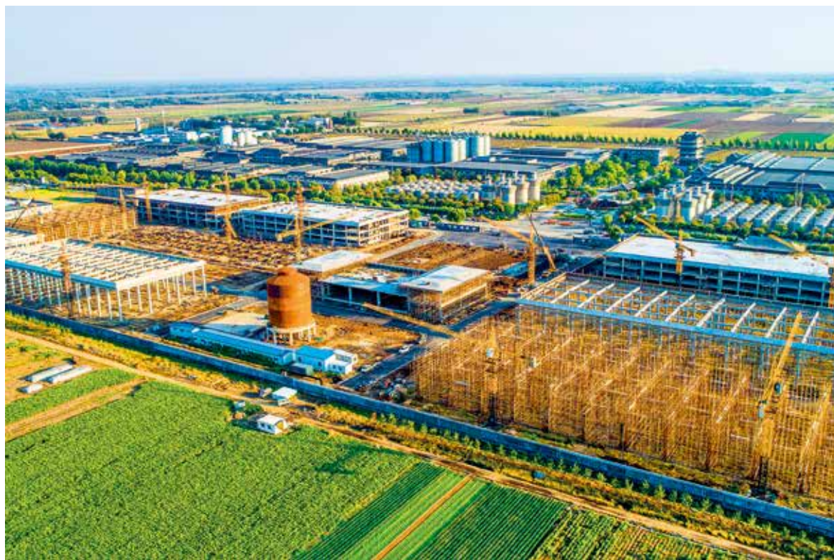
山东景酒智能生产配置中心在建项目
