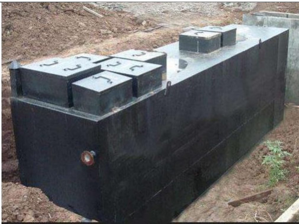
5.1-5 农村一体化污水处理设备
